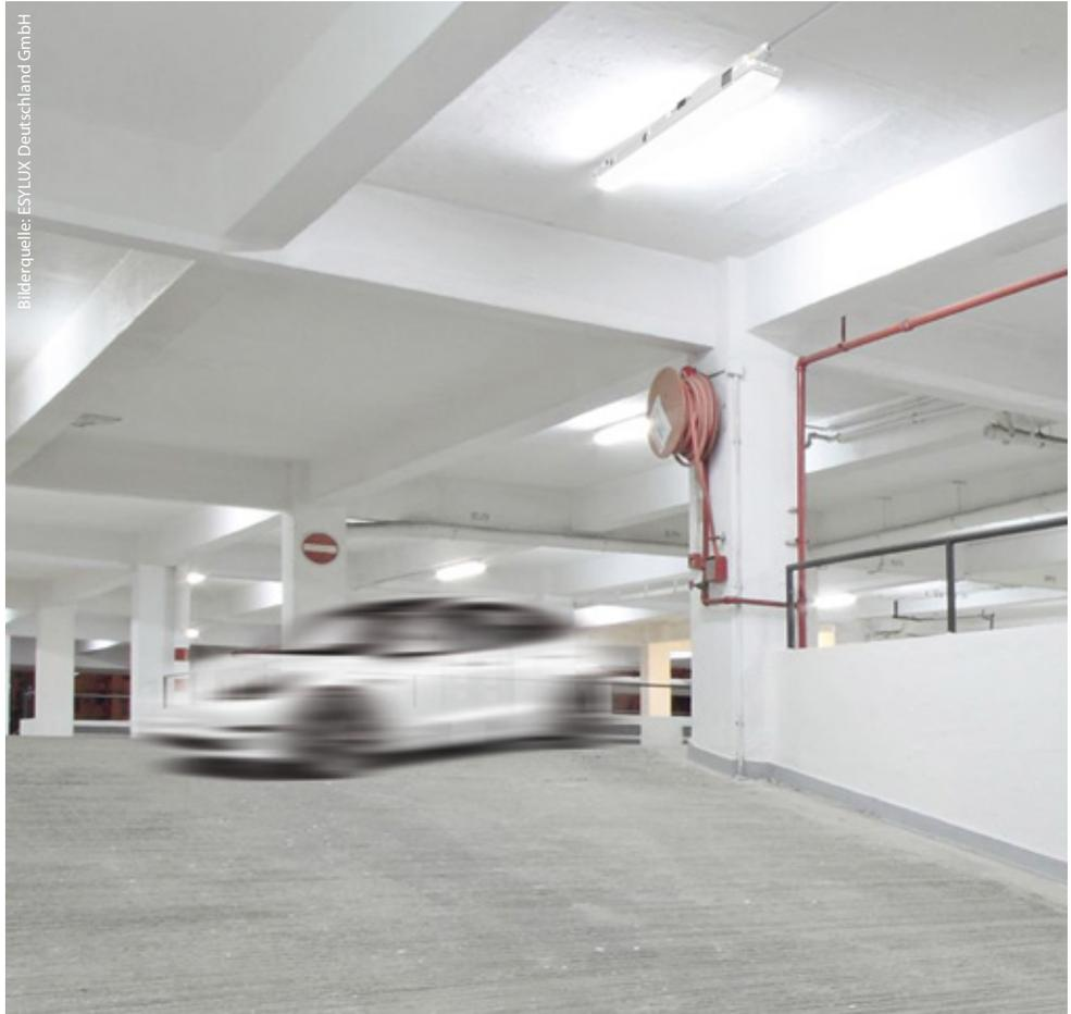
Die **OLIVIA-2-Leuchten** von ESYLUX sind **besonders robust und widerstandsfähig**. Dank ihrer IP66- und IK08-Zertifizierung sind sie staubdicht, halten starkem Wasserstrahl stand und sind stoß- sowie schlagfest – genau das Richtige für die Ansprüche von Feuchträumen.
